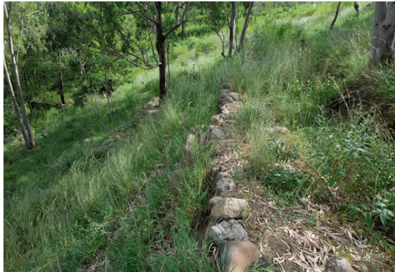
図1 農家の共同作業で作られた石積みによる植林用土保水工（メケレ市内）
