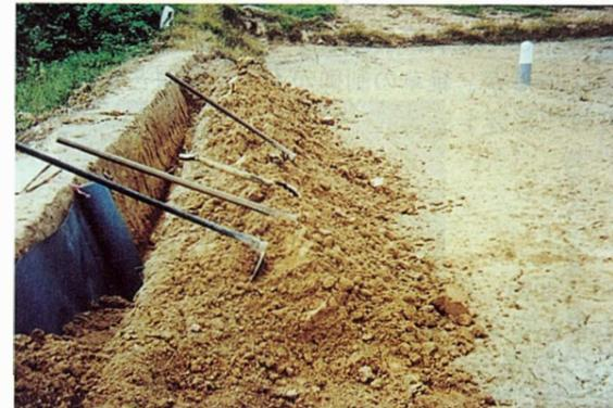
図1 硬質塩ビシートによる改良断面
