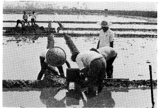
写真2 パーシャルフリューム掘付
