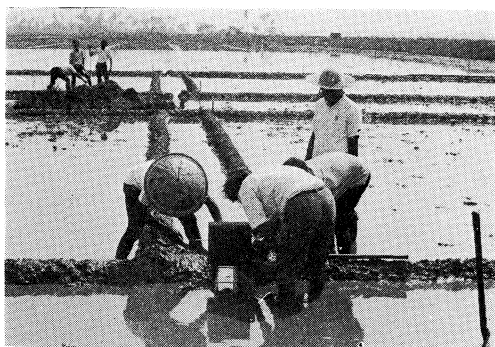
写真2 パーシャルフリューム据付
