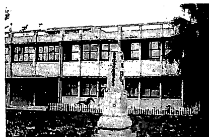
28 台中区農業改良場
