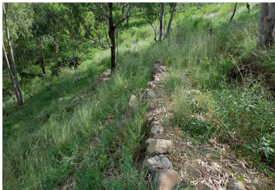
図1 農家の共同作業で作られた石積みによる植林用水土保全工（メケレ市内）
