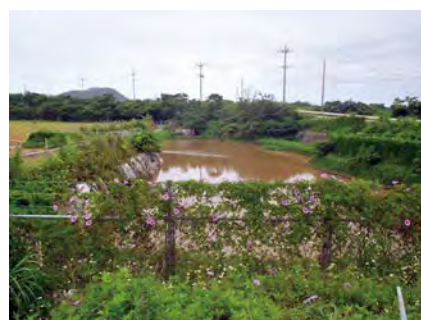
石垣島の畑地内に設置された沈砂池
