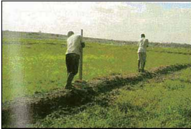
Figure4-15 Bund Construction
