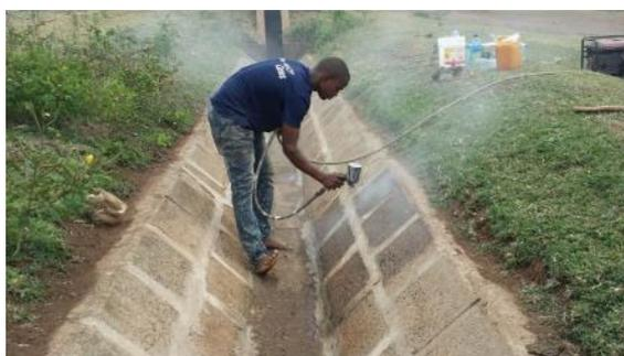
写真 3.6 スプレーガンによる塗装
