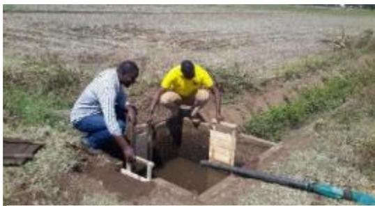
写真 5.6 新しいゲート挿入
