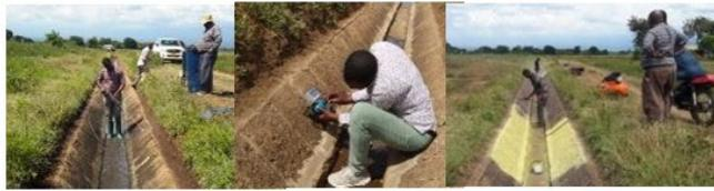
(1) 表面洗浄 (2) 付着強度確認 (3) 樹脂吹き付け
