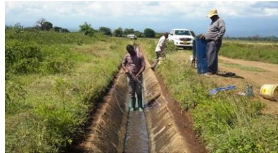
写真 3.3 水路表面洗浄（高圧洗浄機）
