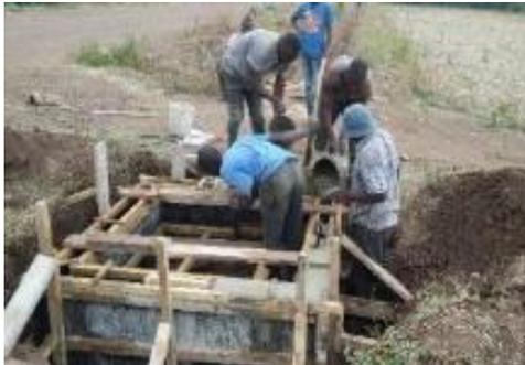
写真 5.22 コンクリート打ち込み
