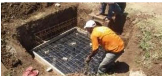
写真 5.18 鉄筋調整
