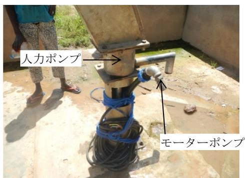
写真 6.4.1 人力ポンプとモーターポンプの設置状況
