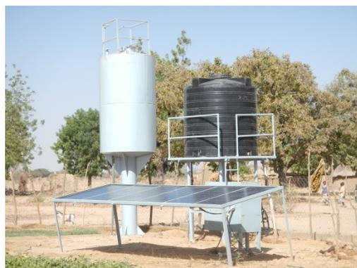
写真 6.7.1 小規模ソーラー揚水システム
