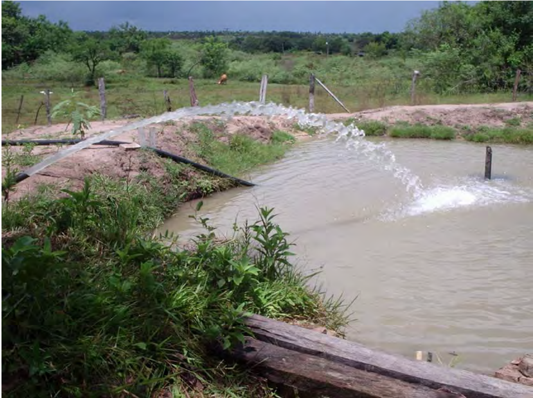
図 8: 長期の干ばつにより 2009 年初めから枯渇したJIRCAS展示圃場用の天水ため池。
