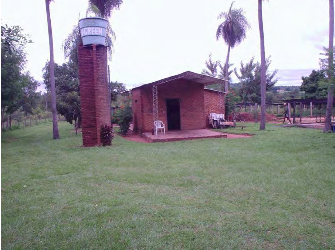
図 6: JIRCAS展示圃場の倉庫、San Roque González市。
