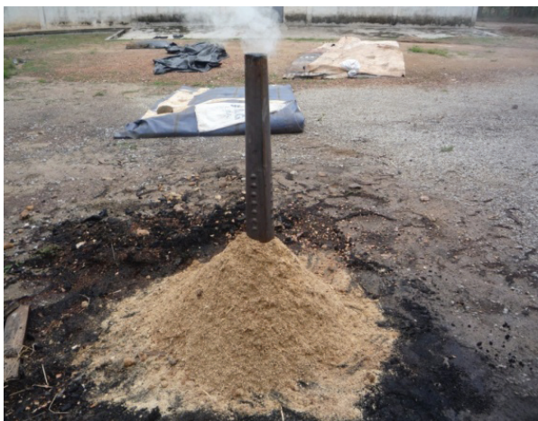
Pour sawdust around the apparatus
