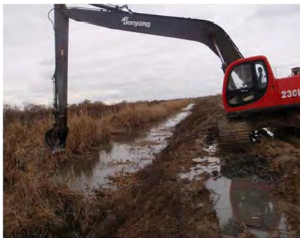
Рисунок 2.4.1 Очистительные работы на коллекторе
