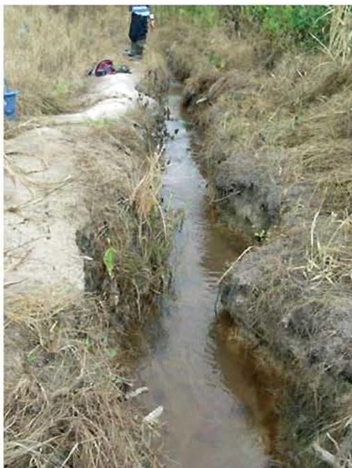
**Figure 4-26 Canal endommagé par l'érosion due à l'eau**
