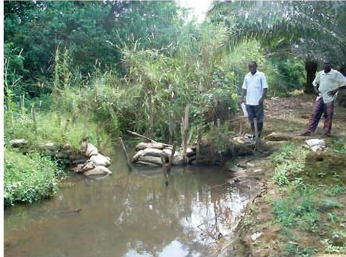
**Figure 4-29 Ancien barrage endommagé**
