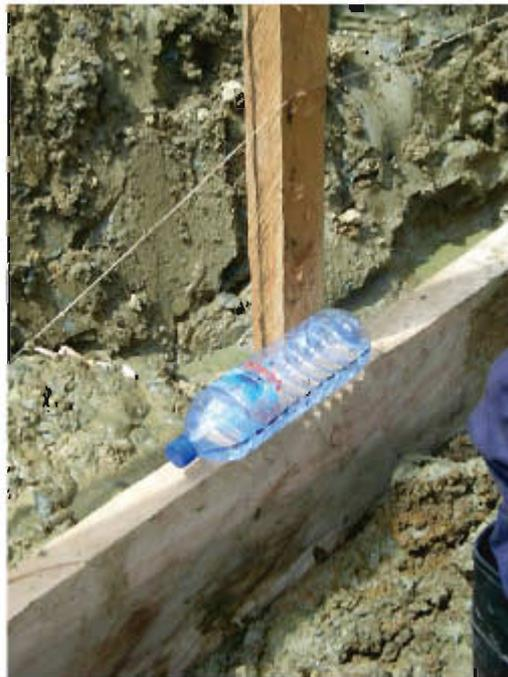
Figure 4-32 Outil de mesure du niveau d'eau simple
