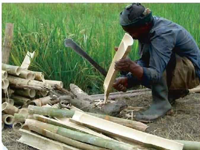
**Figure 4-27 Affûtage de la pointe d'un piquet en bambou**
