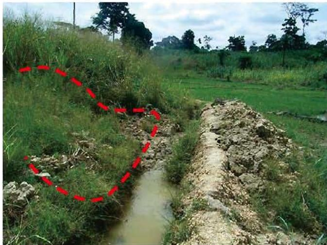
**Figure 4-23** Canal endommagé par un glissement de terrain
