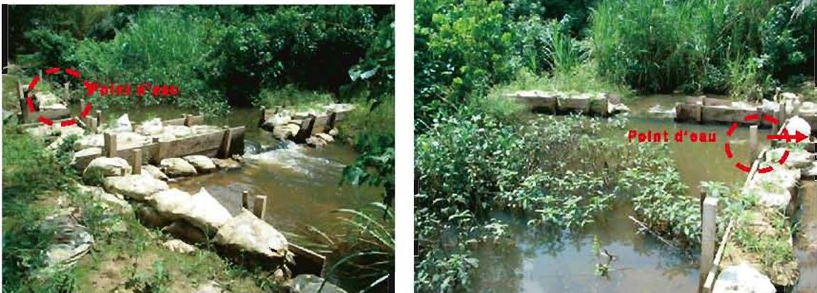
**Figure 4-30 Nouveau barrage (barrage de dérivation à vanne)**
