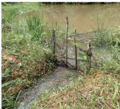
写真1 ため池の取水口（魚が逃げないように網が設置してある）
