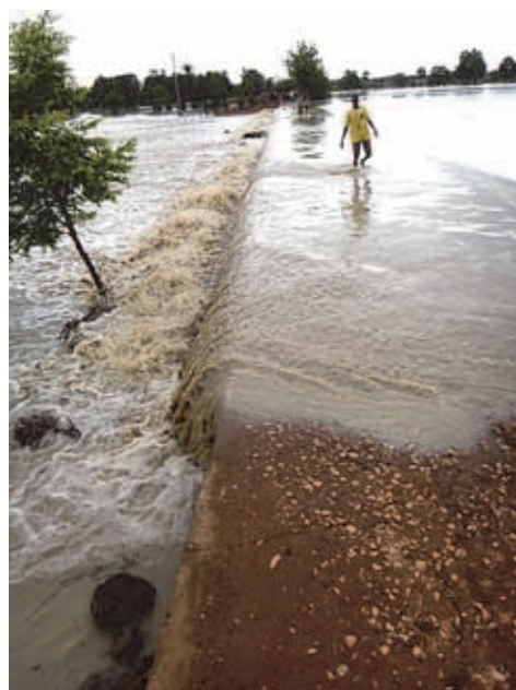
写真4 低地を横切る道路が降雨後の洪水のために通行不能となった（2012年7月）
