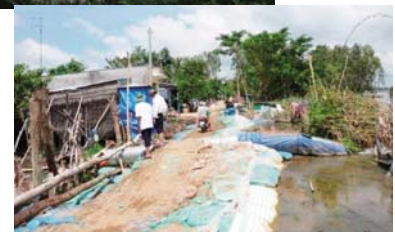
写真2 2011年の洪水で崩壊したフルダイク地区 (上)、土嚢を積んで決壊を防いだフルダイク (下)
