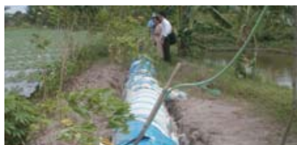
写真2 プラスチック製バイオガス発酵施設 (ベトナム・カントー市)
