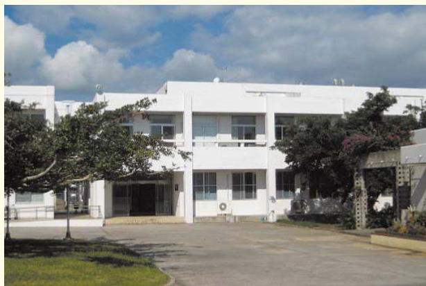
熱帯・島嶼研究拠点 本館（沖縄県石垣市）
