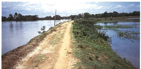
マハナディデルタ（インド東部）の洪水状況 河川（堤防の左側）の水位が堤内地（堤防の右側）の水位より高いため、排水できない。
