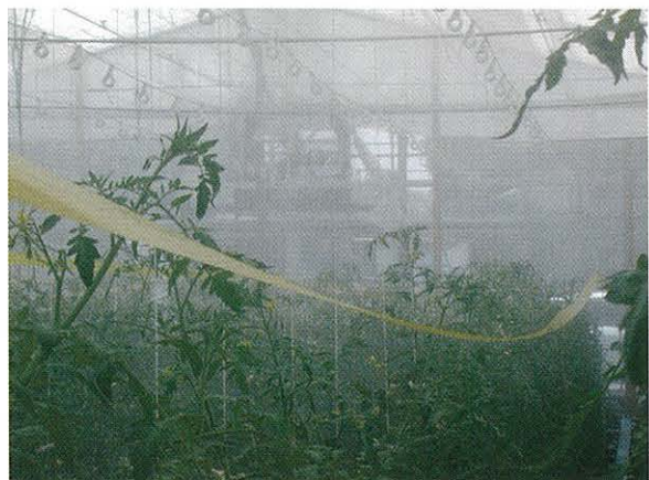
Fig. 3. Fog and fan cooling system.
