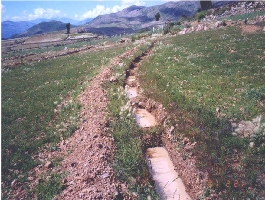
**Foto 20: Zanjas de Infiltración con agua almacenada**
