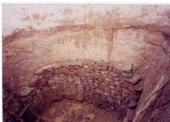
Fotografía 2.2.3 Construcción de pequeño reservorio (tipo piedra con mortero)
