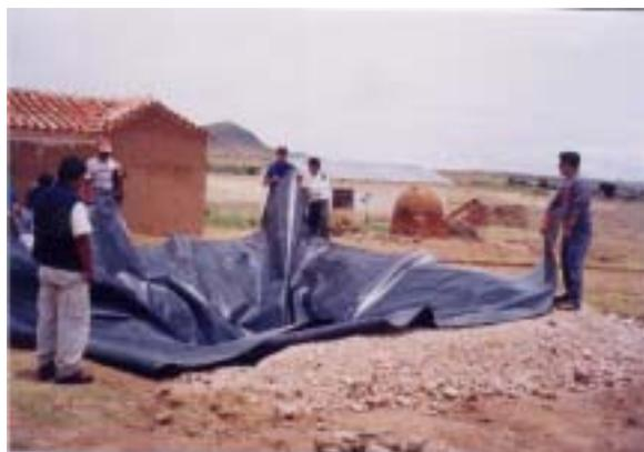
Fotografía 2.3.2 Construcción de pequeño reservorio (tipo carpa impermeable engomado)
