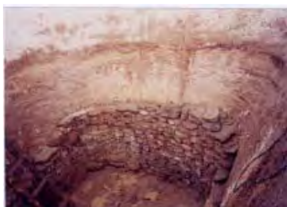
写真 2.3.3 小規模ため池の建設状況 （モルタル練り石積みタイプ）
