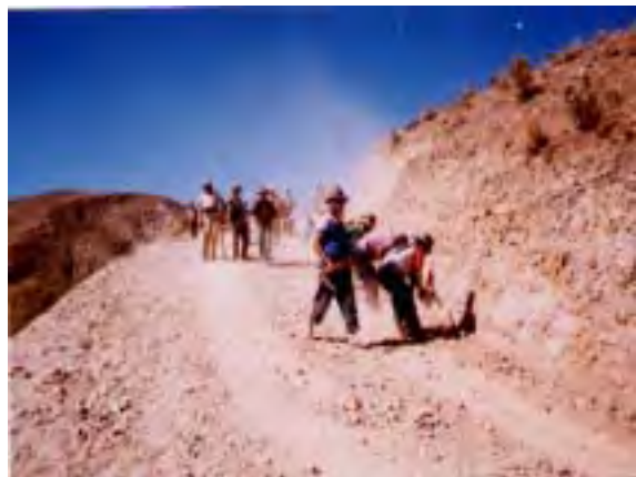
写真 2.4.1 農業用道路の改修作業
