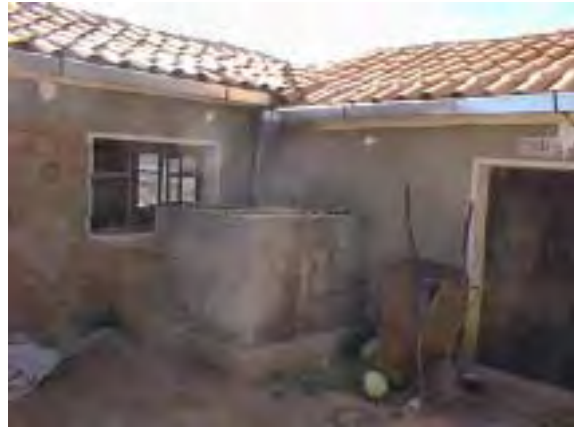
写真 2.3.5 屋根を利用した貯水施設
