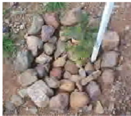
写真4.4.1 石マルチ設置後
