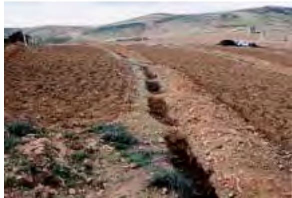
写真 2.2.7 土塁+浸透溝の設置
