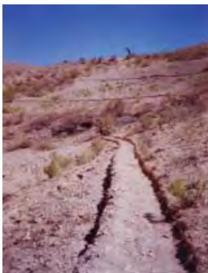
写真 2.2.2 承水路の設置
