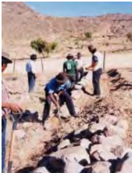
写真 2.2.6 石積みの設置 2 (溝掘りと石材の設置)
