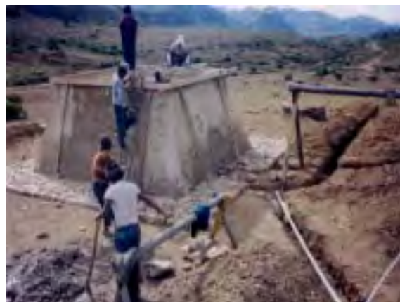
写真 2.4.2 水道施設の建設状況
