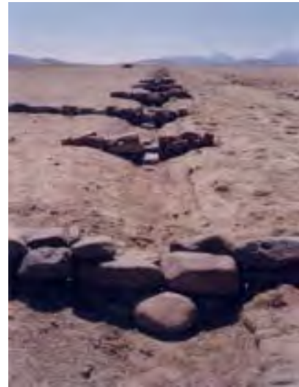
写真 2.2.4 ガリ防止工の設置
