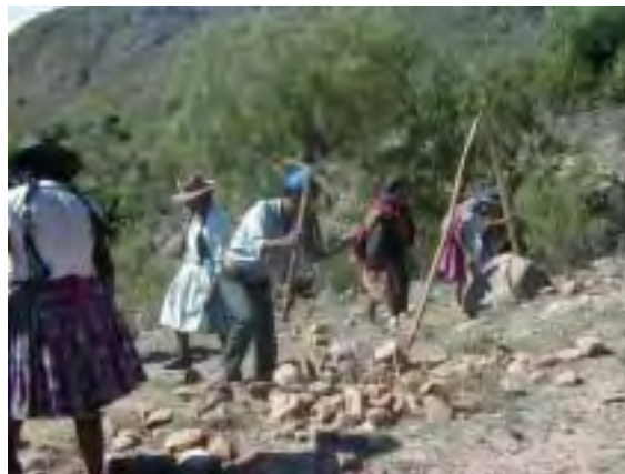
写真 2.2.5 石積みの設置 1 (等高線の測量と石材の収集)
