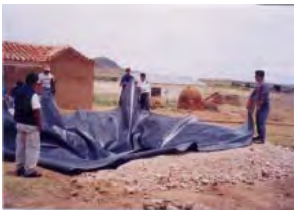
写真 2.3.2 小規模ため池の建設状況 （不透水性ゴムシートタイプ）
