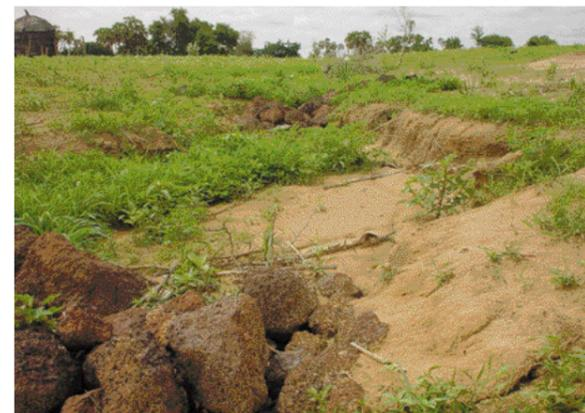
Le fait de mettre des pierres dans les voies d'eau des ravins s'étant formés dans les terres de culture a permis de réduire la vitesse de ruissellement, de favoriser l'ensablement, et de limiter l'agrandissement du ravin.
