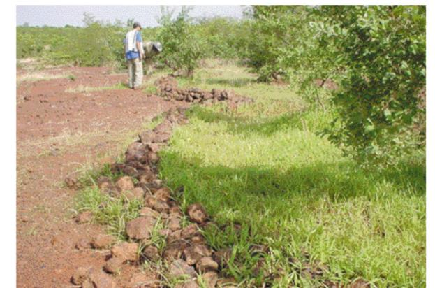
Du côté amont des diguettes en pierres, l'accumulation de sol fin a permis la régénération végétale
