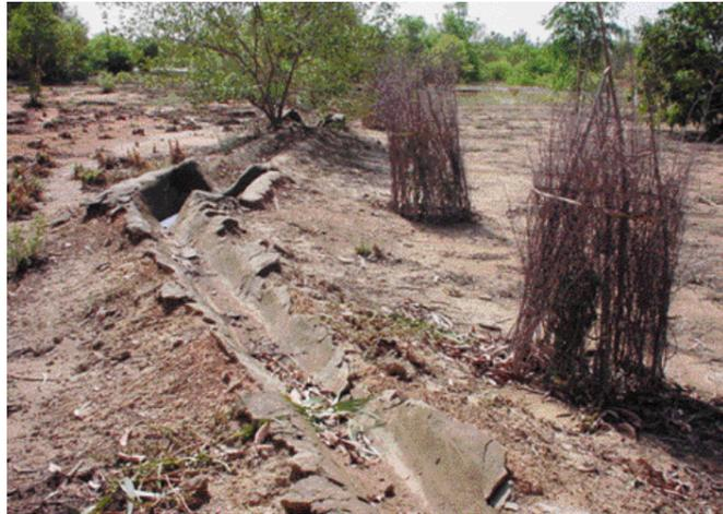
[Canaux en briques séchées au soleil + garniture de mortier] devenus inutilisables à cause de dégâts
