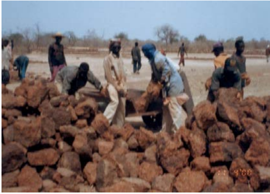
集積した石の積込・運搬
