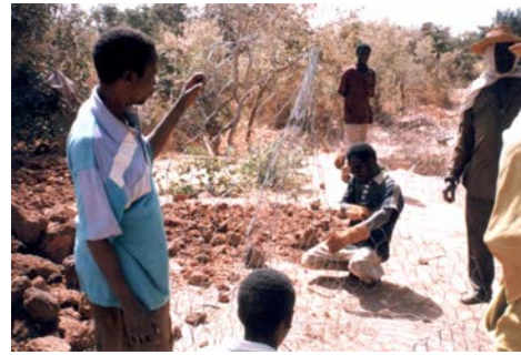
フトン籠組み立て
