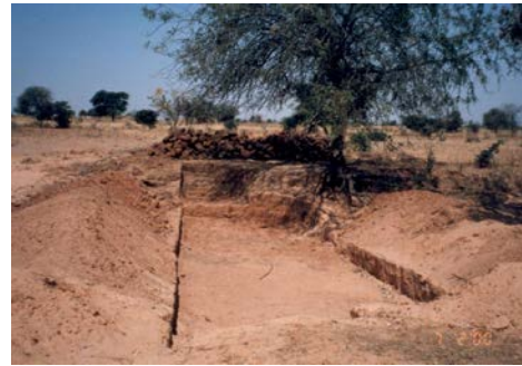
基礎掘削完了
