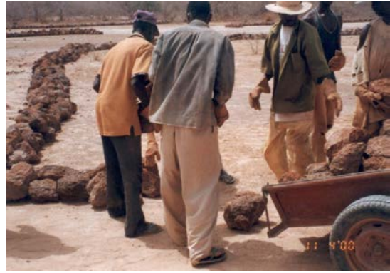
石畦の設置作業
