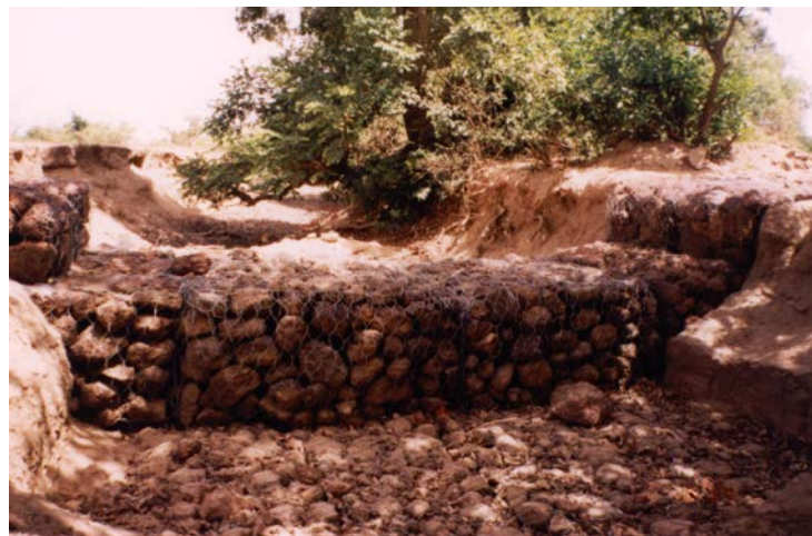
図3.2.5.4 フトン管を用いた大規模な補修例
