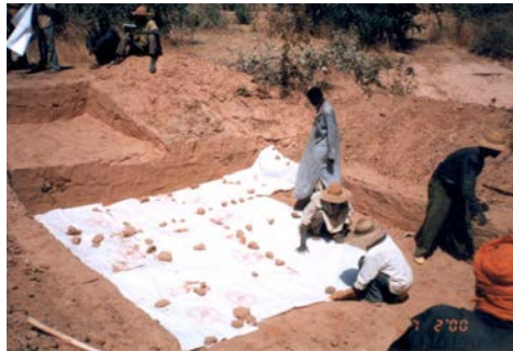
洗掘防止シート敷設
