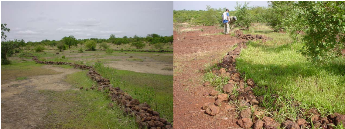
石畦の設置状況
