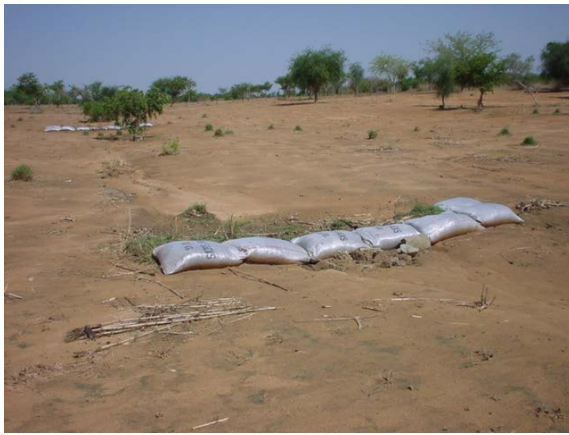
土嚢列の設置状況
