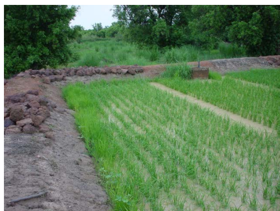
「小堤防を設置した氾濫原水田」 小堤防法面は、石材を張って保護し ている
