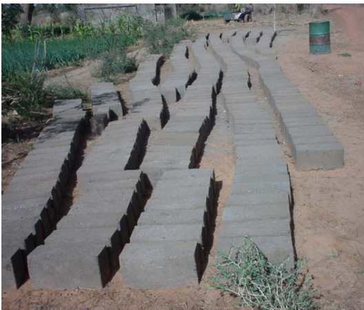
コンクリートブロックの製造作業
