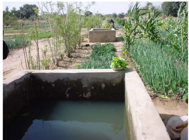
完成したコンクリートブロック水槽
