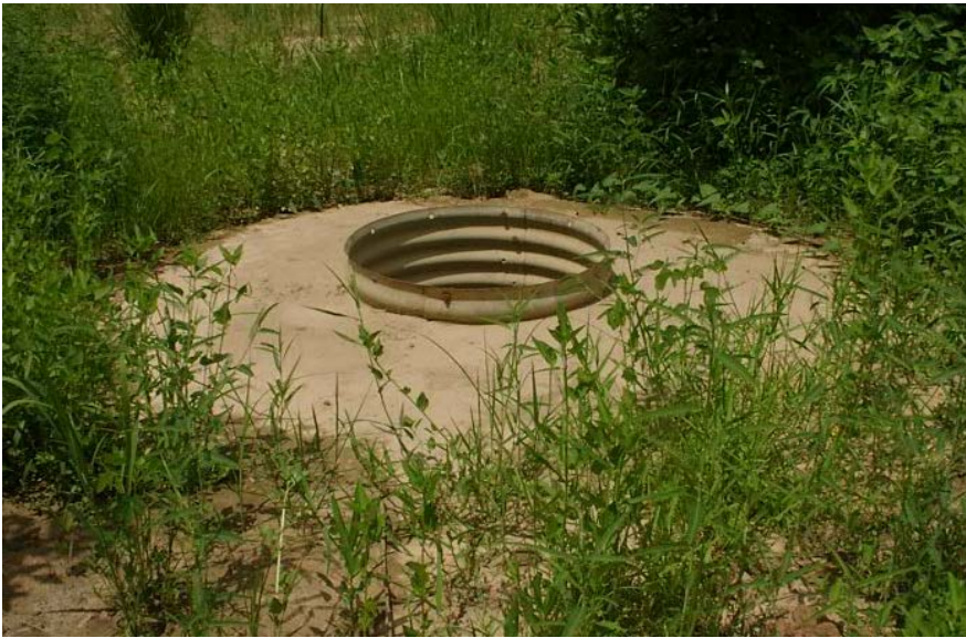
図4. 4. 2. 2 コルゲート管を用いた半伝統的井戸（口径1m）
