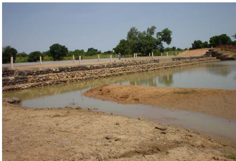
図4. 2. 2. 6 下流側から見たマゴダム洪水吐
