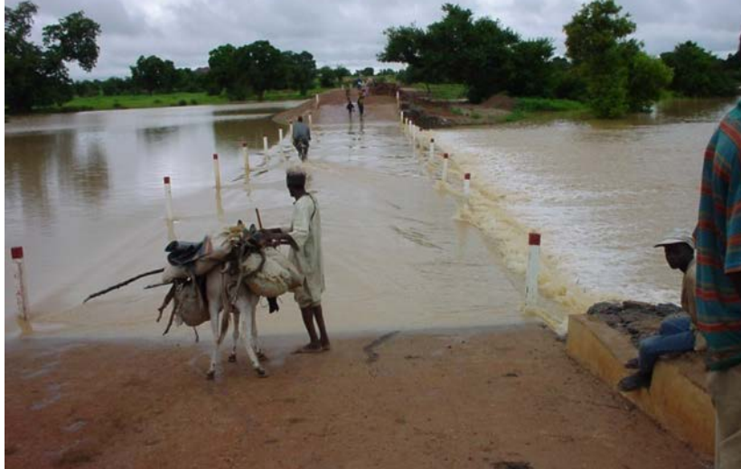
図4. 2. 2. 5 洪水吐を越流する流出水
