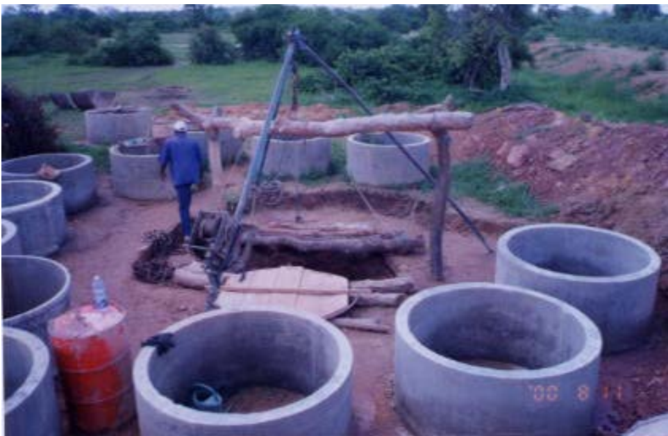
図 4. 4. 2. 1 近代的大口径井戸の設置状況
