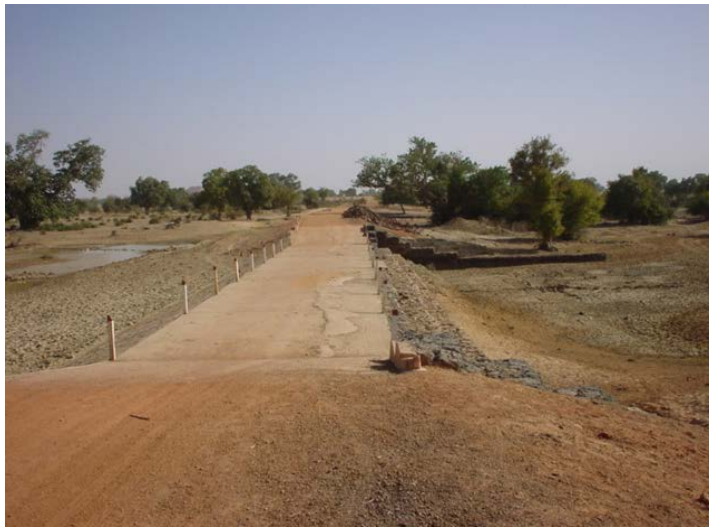
図 4. 2. 2. 1 乾季のマゴダム洪水吐
