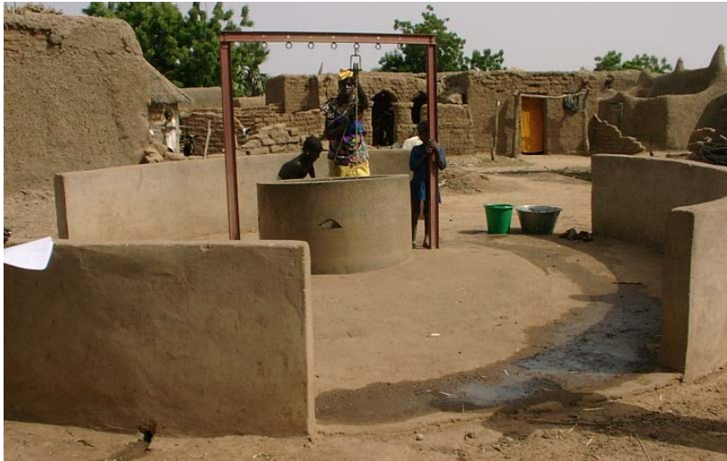
図4. 4. 2. 7 近代的大口径井戸の上部構造の例（2）
