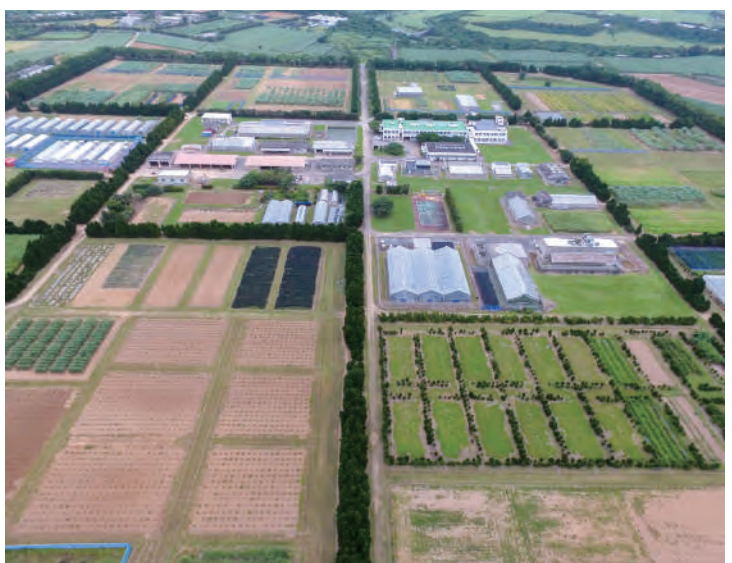
熱帯・島嶼研究拠点の全景
