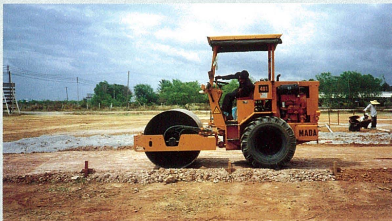
図二 現場締固め試験の状況(使用機械は振動ローラ)
