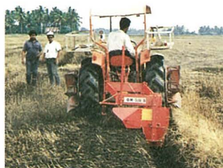
オーガトレンチャによる排水溝づくり
