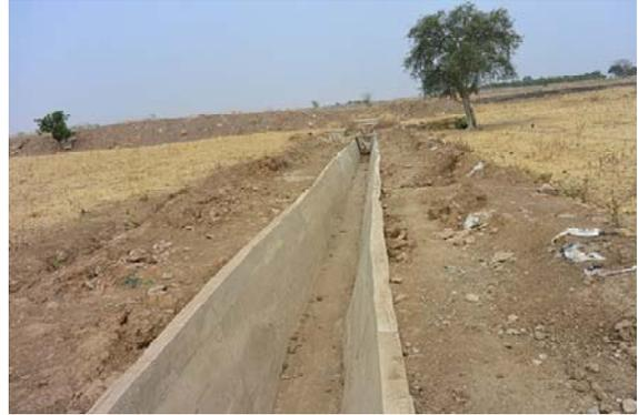
図 2.14 導水路 施工完了
