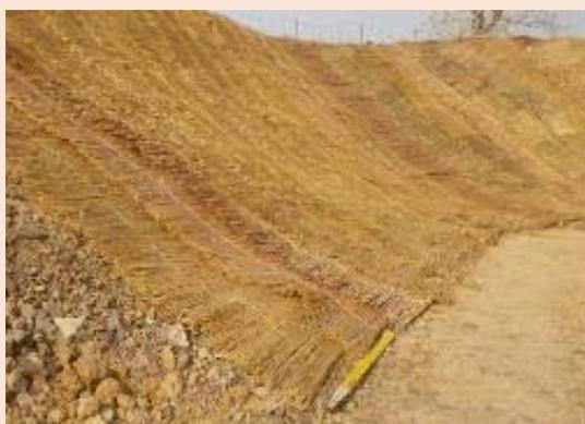
図 2.24 屋根材による法面保護
