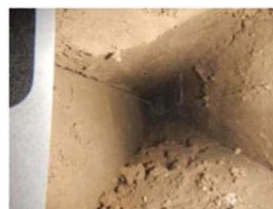
Кротовое дрена после строительства
