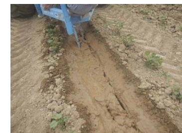
Строительство кротовых дрен сразу после полива
