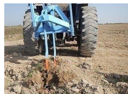
図 4.3.12 穿孔機の浮き上がり
