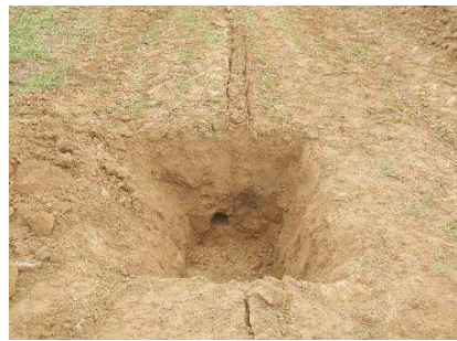
カットドレーンの空洞部
