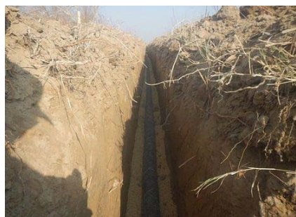
浅層暗渠排水の吸水管
