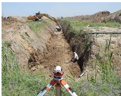
深い暗渠排水の掘削断面
