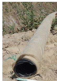
敷設される吸水管
