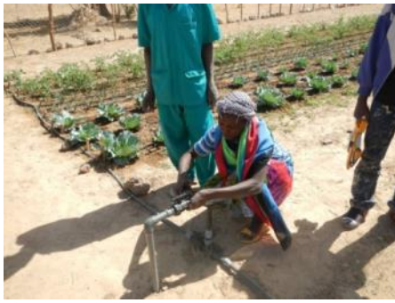
Photo 6.5.4 Ouverture du robinet pour l'irrigation goutte-à-goutte
