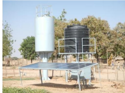
Photo 6.7.1 Petit système de pompage solaire
