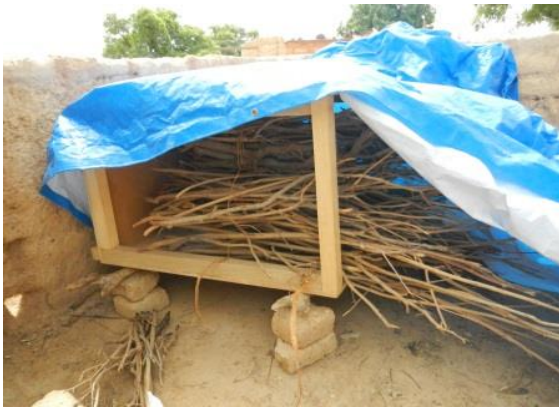
Photo 4.7.4 Stockage de bois
