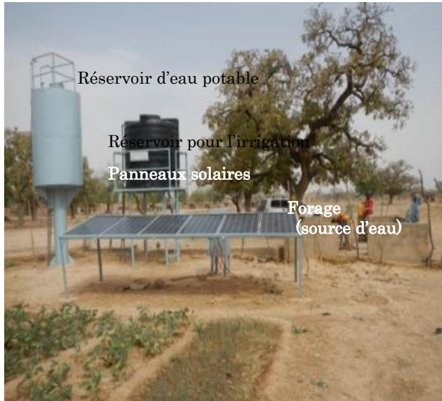
Photo 6.4.1 Système de pompage par énergie solaire photovoltaïque mis en place dans la présente étude
