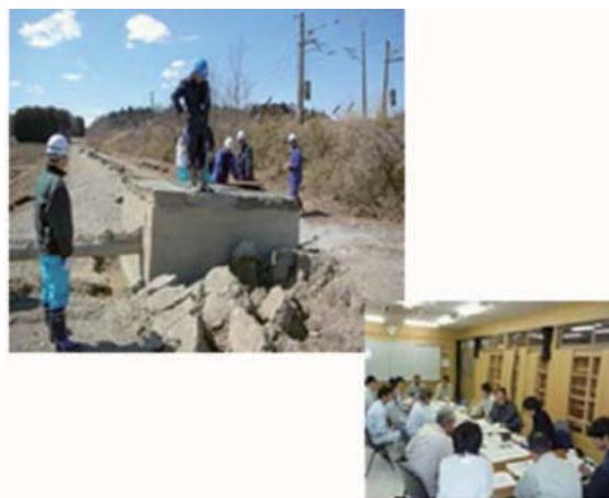
福島県のパイプラインの被害調査
