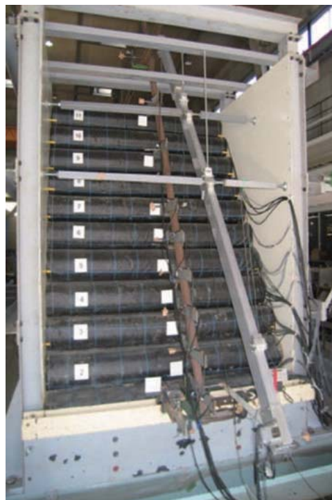
ジオテキスタイル巻込み 工法で構築した壁面
