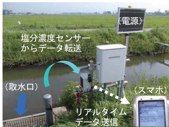
塩分濃度監視システム
