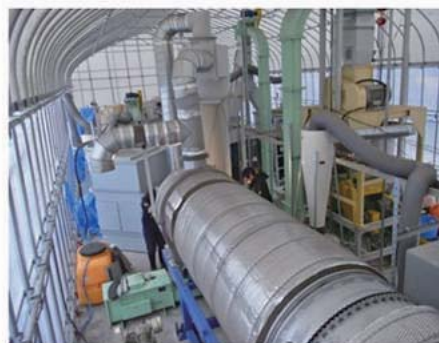
減容化設備全景(幅7m,奥行20m)
