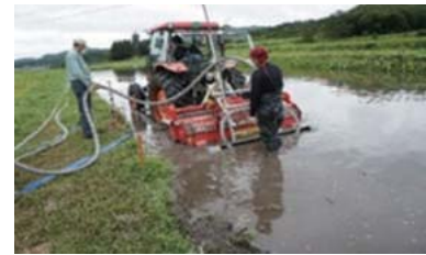
大規模水田での土壌攪拌・吸引作業の流れ
