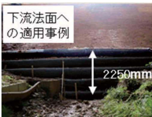
老朽化ため池のジオテキスタイル巻込み工法による改修事例
