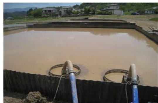
懸濁水の排水状況
