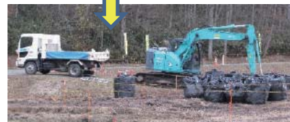
パワーショベルによる フレコン詰め・搬出
