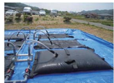
泥土の袋詰簡易脱水状況（共通）
