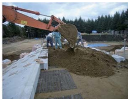
セメント改良土の撒出し
