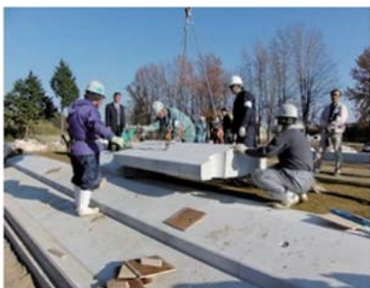
ジオテキブロックの据付
