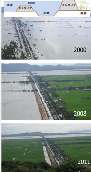
図1 アンジャン省のフルダイクの普及(上:両岸ともセミダイク、中:右側フルダイク、左側セミダイク、下:両岸ともフルダイク)
