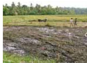
水田復旧工法は、耕耘機により雑草を鋤込み、土壌中で自然分解させる工法を採用した。具体的には、
